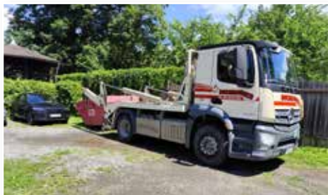
Über 3 Tonnen Material wurden vom Unterbau des alten Bodes im Pavillon entsorgt
