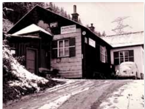
Berggasthof Präbichl 1. Baustufe
