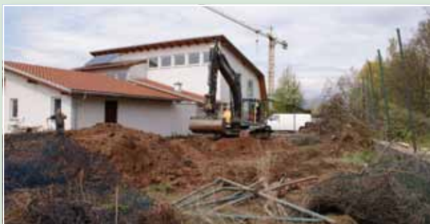
Die Räumarbeiten haben begonnen
